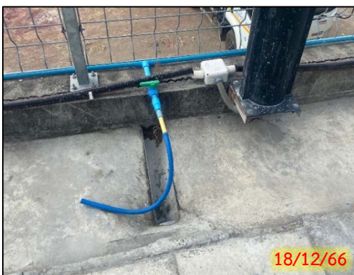
รูปที่ 2.2-9 จุดสำหรับล้างล้อรถของพื้นที่โครงการ
